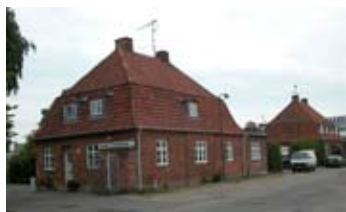
De to bevaringsværdige bygninger.
